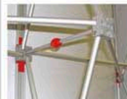
Nodo estructural mediante tornillos
